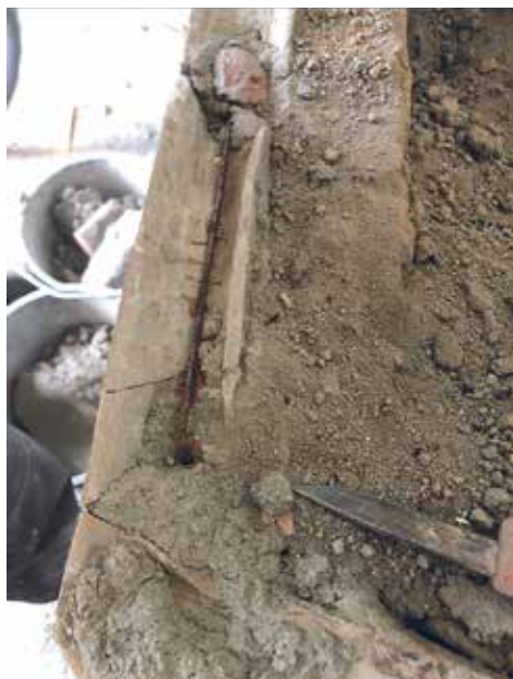
Krammeltråd kan sitta i ovkant eller i mitten. Vanligtvis sitter de mellan vardera kakel. Använd en tång för att klippa bort tråden.
