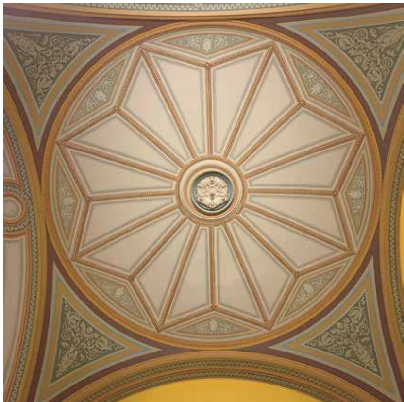
Sprinkler infälld i takrosetten på Nationalmuseum.
