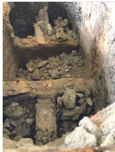
Det är mycket tegel och lerbruk i en kakelugn som väger 1-1,5 ton uppsatt och klar.
