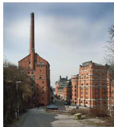
Till vänster i bild Ångpannhuset från 1920-talet, till höger Münchenbryggeriet uppfört på 1890-talet och senare tillbyggt.
